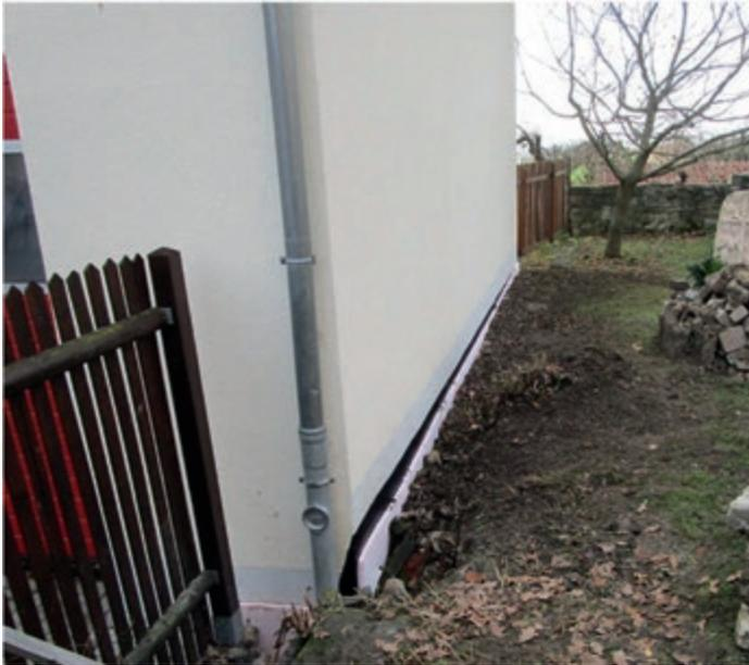
Das im Jahr 2016 neu errichtete Feuerwehrgerätehaus in dem OT Bechstedt-Wagd zeigte einen Feuchtigkeitsschaden im Sockelbereich der nördlichen Innenwand. Daher erfolgte die Freilegung des äußeren Sockels, dessen Säuberung und Trockenlegung. Zudem wurde eine Dickbeschichtung aufgebracht und eine Drainageleitung verlegt.
