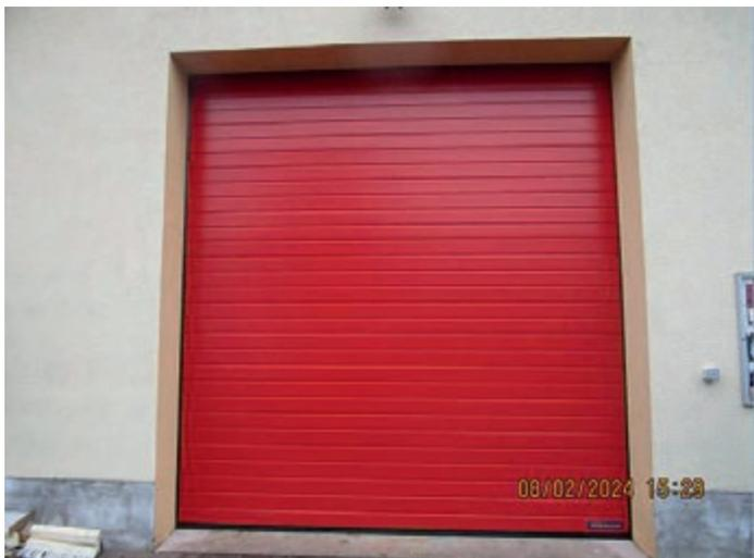
Das Tor in dem Feuerwehrgerätehaus Holzhausen war ungedämmt und hatte einen Anfahrtschaden. Daher wurde die Firma Hörmann mit der Lieferung und den Einbau eines neues Sektionaltores beauftragt.
