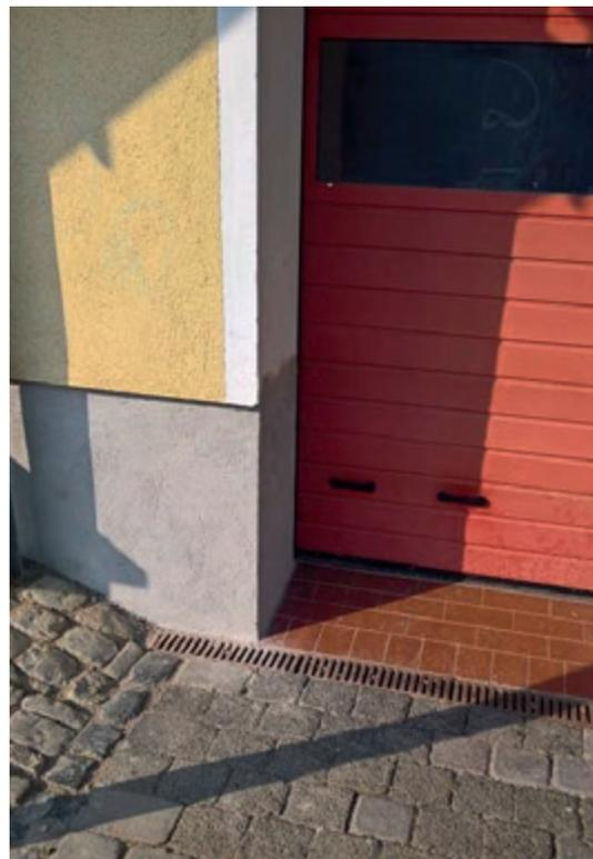
In Kirchheim in dem Feuerwehrgerätehaus musste ein Teil des Sockels saniert werden. Durch Feuchteinwirkungen und ausblühende Salze war der Sockel linksseitig des Tores stark in Mitleidenschaft gezogen; die Führungsschiene des Tores stark korrodiert. Durch ein Betonfundament konnte der Sockel neu unterfangen werden und die Führungsschiene des Tores erneuert werden. Die Maßnahme wurde durch den gemeindlichen Bauhof durchgeführt.
